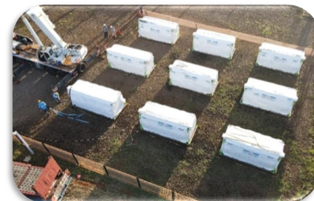
Fotos: ISA Energia – Fase de implantação do equipamento SSSC na Subestação Ribeirão Preto 138 kV
